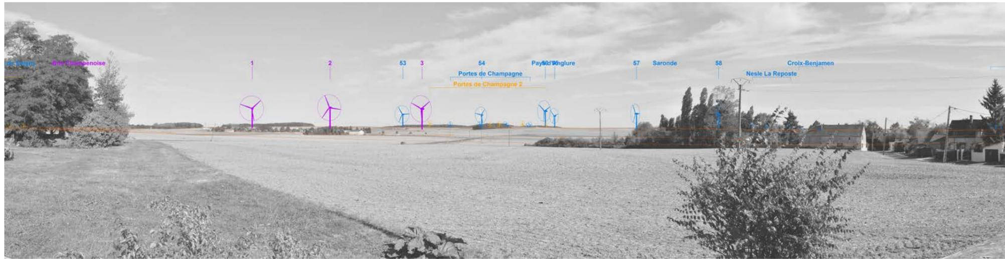
Variante 3a : hauteur totale 150 m ; diamètre de rotor 117 m ; hauteur du mat 91,5 m
