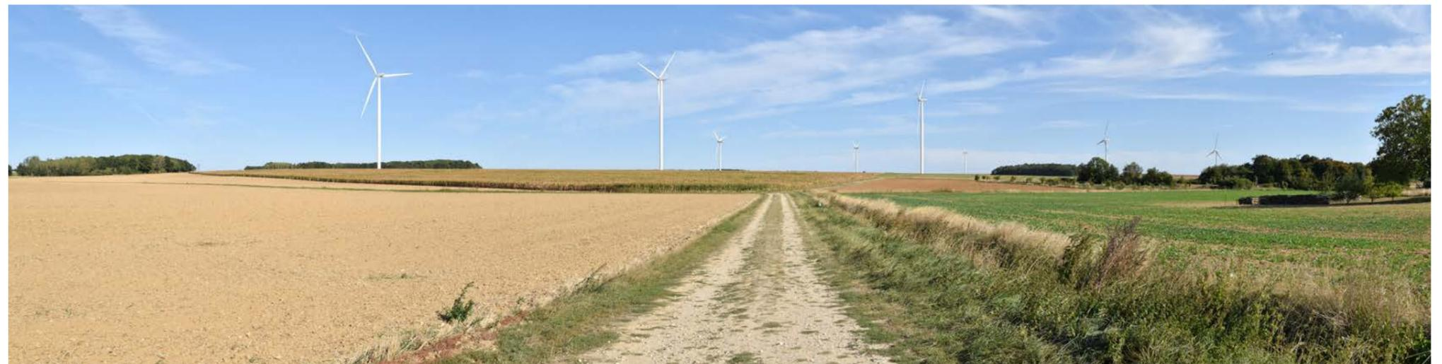
Variante 3c : hauteur totale 180 m ; diamètre de rotor 117 m ; hauteur du mat 121,5 m
